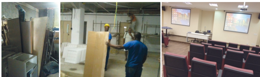
Figura 10. Fotos da construção do Auditório do Núcleo Perinatal HUPE-UERJ (2013-2014)
