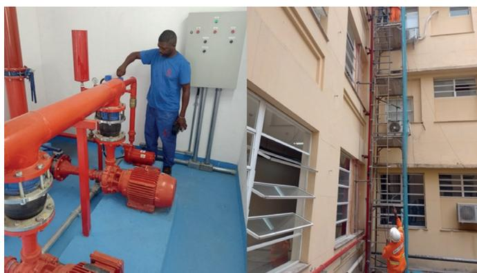
*Sistema de Hidrantes, detecção e Alarme para combate a incêndio no prédio principal e instalação de Máquinas de Pressurização do Sistema*
