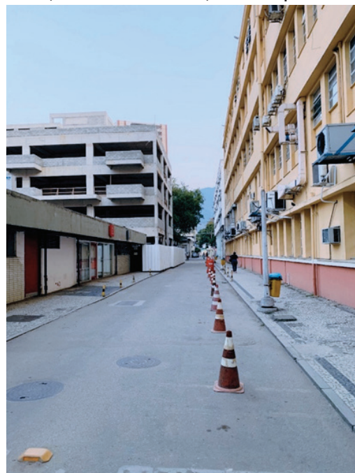
O velho e o novo. Na foto, vemos (à direita) o prédio-sede, estrutura que já possui mais 70 anos de construção, e passa por reformas; e (à esquerda) o novo prédio da Nefrologia, que está sendo construído, e que possibilitará considerável expansão na realização de transplantes - de rins e de outros órgãos também. É preocupação do Hupe preservar sua história, harmonizando-a com as novas tecnologias.
