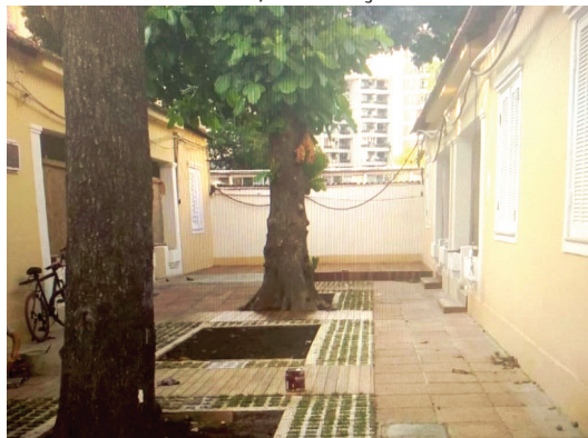
Em conclusão, reforma das casas da Psiquiatria e da área externa
